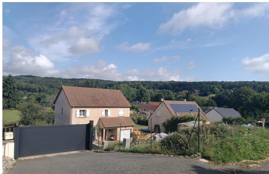
Intégration paysagère de panneaux photovoltaïques chez des particuliers – Touffreville
