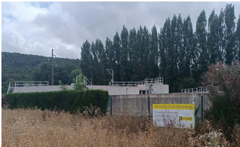
Station de traitement des eaux usées – Fleury-sur-Andelle
