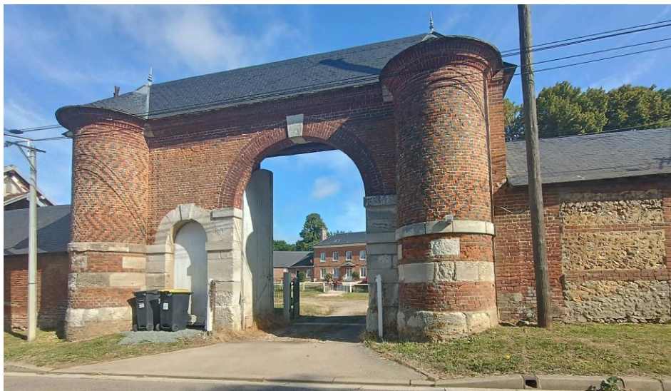
Élément remarquable du patrimoine (ferme fortifiée) Houville-en-Vexin
