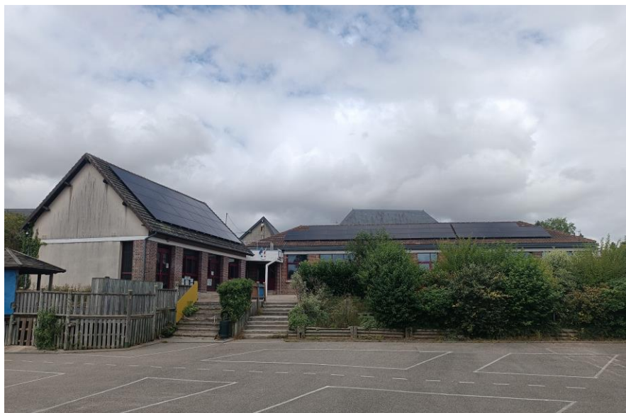
Intégration paysagère de panneaux photovoltaïques sur un bâtiment public – Bourg-Beaudouin
