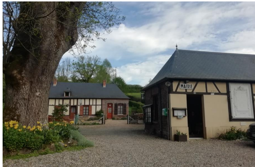
Aménagements perméables autour de la mairie – Lorleau
