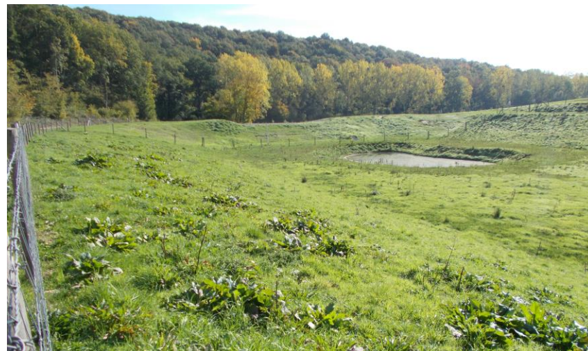
Ouvrage tampon favorisant l'infiltration des eaux pluviales Radepont
