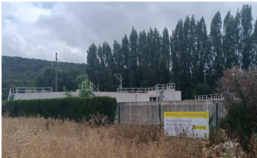
Station de traitement des eaux usées – Fleury-sur-Andelle
