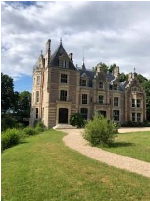
Image n°3 – Prise de vue façade arrière
