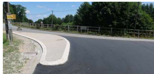
RADEPONT | ROUTE DE FUMECHONT Aménagement de sécurité d'un carrefour dangereux Mise en place d'une limitation de vitesse à 50 km/h Montant TTC : 25 268,50 € Durée des travaux : 3 semaines
