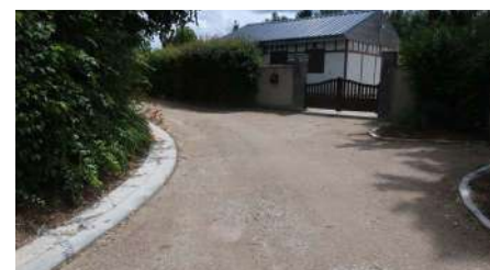
BOSQUENTIN | CHEMIN DE SAINTE-ANNE Travaux d'assainissement en traverse Montant TTC : 63 324,45 € Durée des travaux : 1 mois
