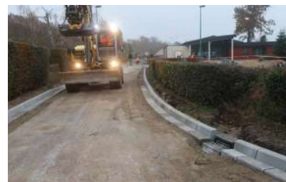
VANDRIMARE | RUE DES SPORTS Travaux d'assainissement en traverse Montant TTC : 36 725,92 € Durée des travaux : 3 semaines
