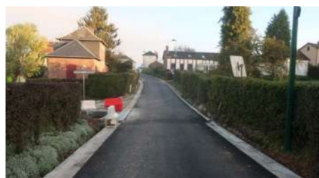
LES HOGUES | CHEMIN DE L'ARGILIERE Maîtrise des écoulements d'eau de pluie Montant TTC : 58 792,91 € LES HOGUES | RUE SAINTE-HONORINE Travaux d'assainissement en traverse Montant TTC : 135 075,78 € Durée des travaux : 2,5 mois
