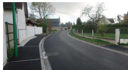
BACQUEVILLE | ROUTE DE BONNEMARE Travaux d'assainissement en traverse Montant TTC : 348 257,48 € Durée des travaux : 3 mois
