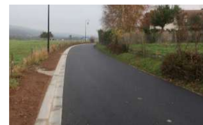
VASCŒUIL | RUE DE LA PLAINE Création de caniveaux pour gérer les eaux de pluie Montant TTC : 70 508,09 € Durée des travaux : 1 mois
