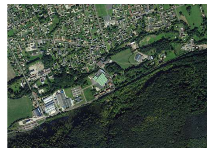
Vue aérienne de la ZAE Les Hautes Rives à Romilly-sur-Andelle
