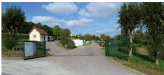
La déchèterie de Charleval.
