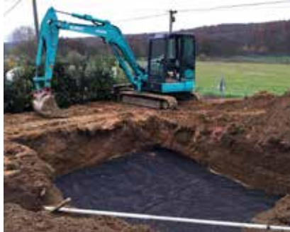
Travaux de réhabilitation d'un assainissement non collectif à Ménequeville.
