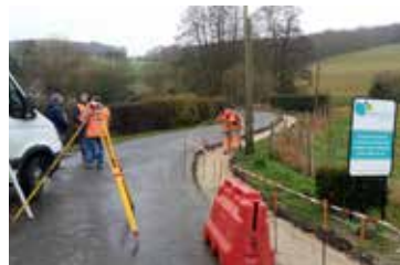
Travaux neufs, rue de la Lieure à Lorleau
