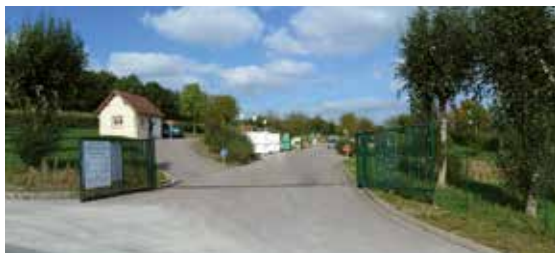
La déchèterie de Charleval.
