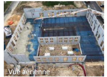
Pose des pré-murs
